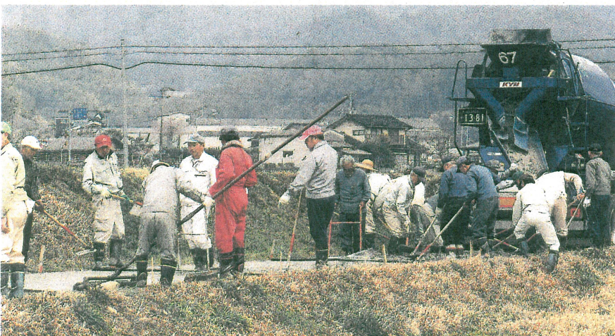
①会員の皆さん ②総出で農道の舗装作業に汗を流す
